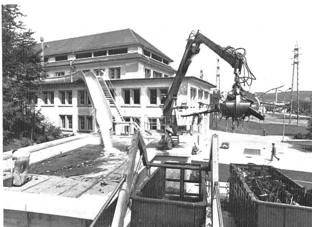
Das Geschwemmsel, das eine Reinigungsmaschine am Rechen des Aare-Kraftwerkes Gösgen aus dem Flusse zieht, gelangt durch eine Rinne, links oben, in ein Auffangbecken, links unten, von wo es mit einem Kran in Container verladen wird.
