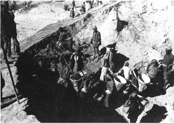
Bild 7. Strassenbau in den nepalesischen Hügeln: Menschen statt Maschinen bewältigen alle Arbeiten. In den sogenannten Tokos (Rückenkörbe) wird der Aushub auf die Seite gebracht. Das Bild stammt von den Arbeiten des Schweizer Projektes der Jiri-Lamusangu-Strasse.
