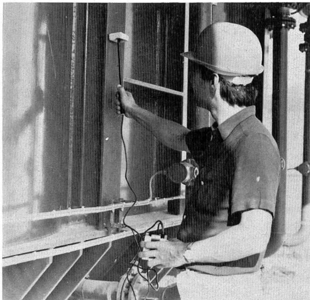
Bild 9. Porenkontrolle mittels Pin-Hole-Detektor.
