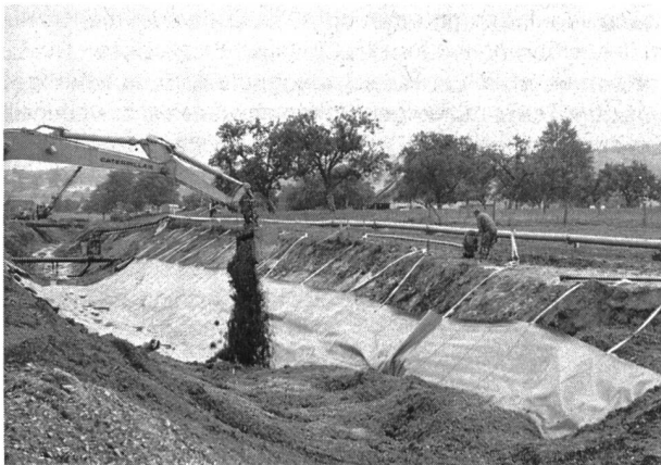
Bild 4. Aufschütten von kiesigem Material auf die verlegten und verschweissten Kunststoff-Dichtungsbahnen. Um Überbeanspruchungen des Materials zu vermeiden, wird das Schüttgut nicht direkt aus der Baggerschaufel auf die Dichtung geschüttet.
