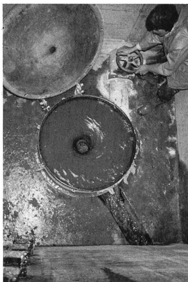
Bild links. Wirbeldrossel mit geöffnetem Deckel an einem Regenüberlaufbecken.
