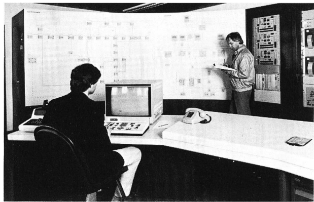
Das Herz des Betriebszentrums: Meldebild mit integrierter Wasser-, Gas- und Elektrizitätsversorgung.
