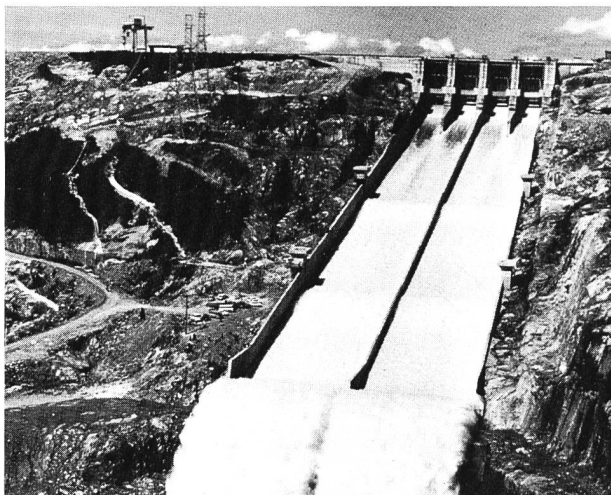
Bild 2. Hochwasser, das über die Sperre von Emborraçao (Brasilien) abgeleitet wird (Titelblatt der Fachzeitschrift «Water Power and Dam Construction» 35 [1983], Heft 8).
