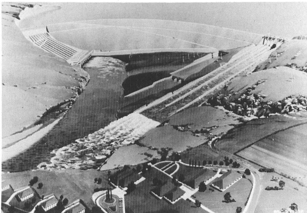
Bild 2. Projektansicht des Wasserkraftwerks «Atatürk». Die installierte Leistung wird 8 × 300 MW betragen, die jährliche Stromproduktion rund 8 Mrd. kWh. BBC Brown Boveri und Sulzer-Escher Wyss werden die gesamte elektrische und hydraulische Ausrüstung liefern.
