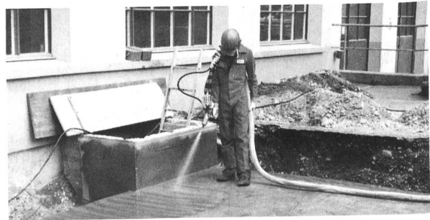
Applikation einer «Vatec»-Unterterrain-Flachdachabdichtung.
