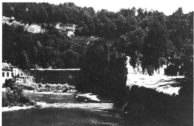
Bild 3. Luftseitige Ansicht der Gewichtstaumauer Pérolles an der Sarine ob Fribourg/FR mit rechts dem Hochwasserentlastungskanal. (Foto des Autors)
