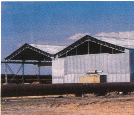
Werkhalle in Algerien
