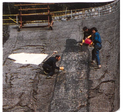
Abdichtungen für Ausgleichsbecken
