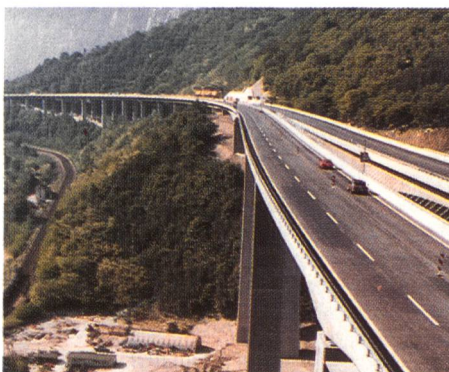
Polyesterbeschichtung auf Viaduktbrüstungen
