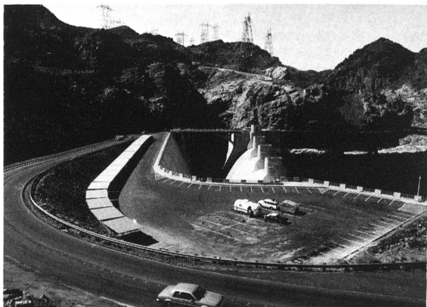
Figure 3. Les deux évacuateurs de crues, installés chacun d'un côté, ont une capacité totale de 11 327 m 3 /s. Dimensions: longueur 198 m, largeur 45 m, hauteur 52 m. Les galeries attenantes ont un diamètre de 15 m.
