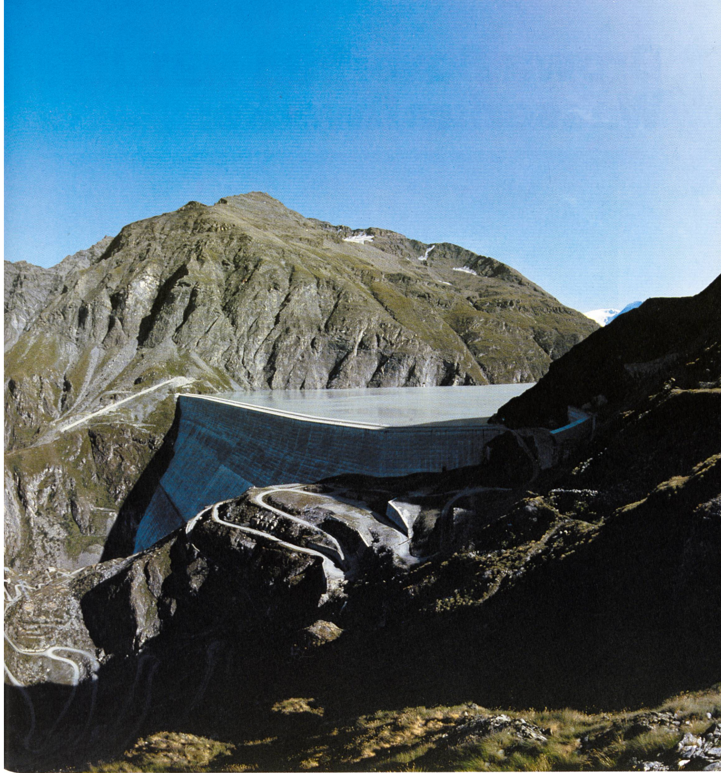
Barrages-poids de la Grande Dixence. D'une hauteur de 285 m, c'est le plus haut barrage du monde. Pour l'aménagement hydro-électrique, des projets d'extension sont présentés (voir page 10–12).
