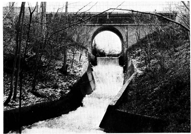
Bild 1. Beim Kleinkraftwerk Roggwil wird ein natürlicher Gefällsprung von 10 m der Langeten bei der Gullenbrücke genutzt.
