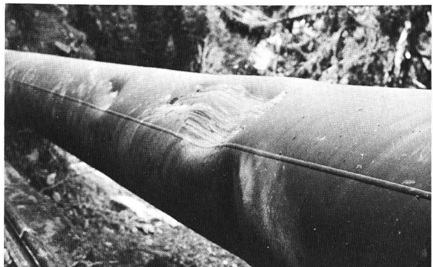
Bilder 5 und 6. Steinschlagschäden an einer Druckleitung. Im Fall von Bild 5 wurde eine 40jährige Druckleitung betroffen; im relativ spröden Material erfolgten Risse. Die Druckleitung Bild 6 aus zähem Material überstand vergleichbaren Steinschlag soweit, dass sie bis zum Auswechseln des Rohrstückes weiterbetrieben werden konnte.
