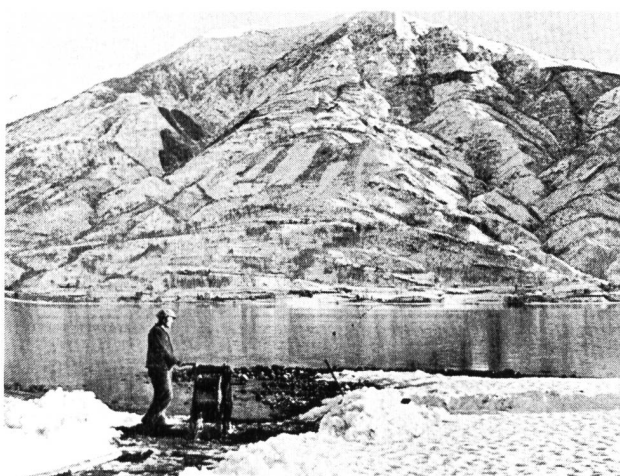
Bild 3. Vermessung des Maggia -Deltas im Januar 1926: Die Lotungen erfolgten längs Profilen, die man mit einem Draht markierte, der von einem Ufer zum anderen gespannt und zusätzlich an Büchsen (als Schwimmkörper) aufgehängt war. Aufnahme: Eidg. Amt für Wasserwirtschaft
