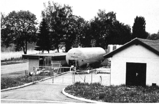
Bild 3a. Fotografische Dokumentation der internen Anlagen. Versorgungsstation mit Sauerstofftank und Betriebsgebäude.
