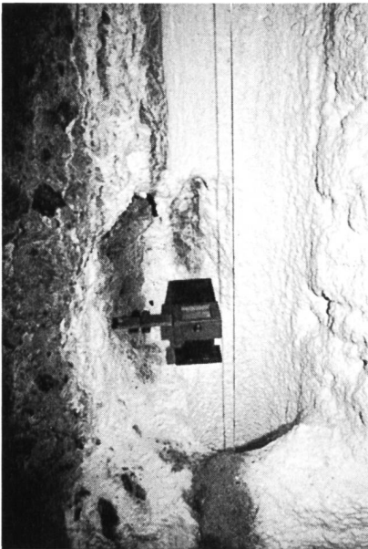
Bild 4. Staumauer Spitallamm. Unverrohrte, versinterte Bohrung mit Loteinrichtungen.
