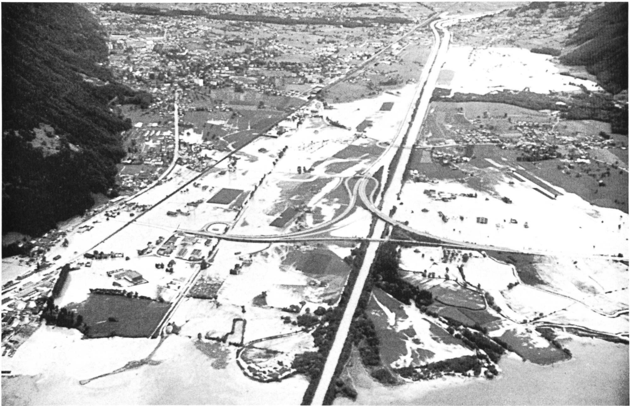
Bild 2. Überflutung der Reussebene am 25. August 1987.
