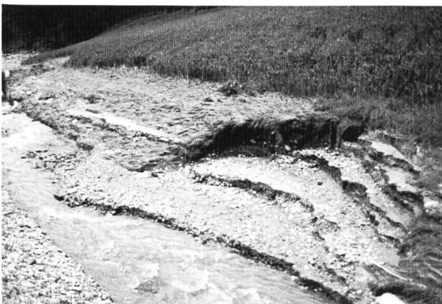
Bild 4. Biembach: Geschiebeablagerungen in den zuvor ausgeräumten Uferabbrüchen. Terrassenförmige Erosion der frischen Auflandungen (3. Juli 1987).
