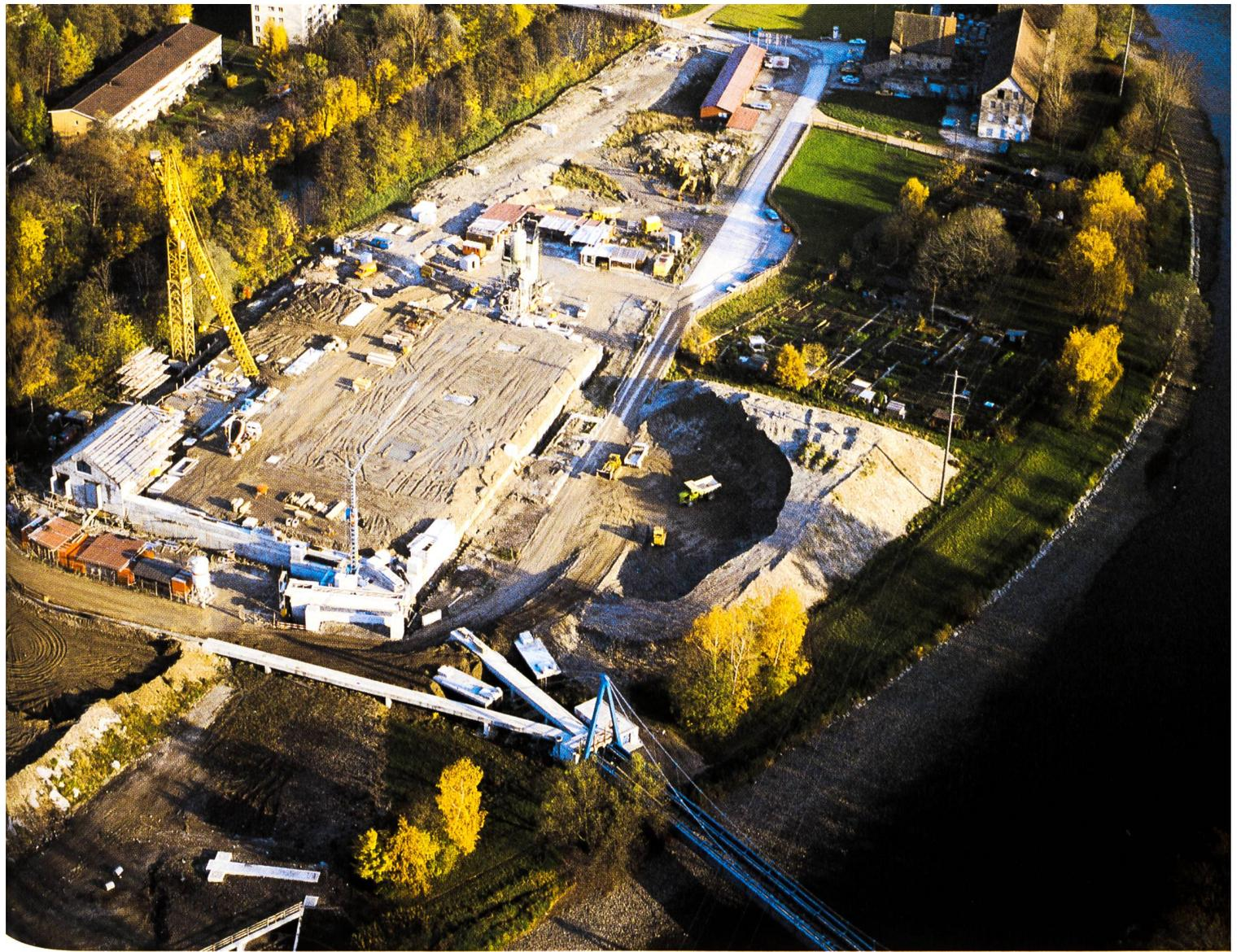
Flugaufnahme der Werdinsel in Zürich mit der Baustelle für das Regenbecken. Die Limmat (rechts im Bild) und der Oberwasserkanal (links oben) fließen gegen den Betrachter. Am unteren Bildrand verbindet die Rohrbrücke das Regenbecken mit der Kläranlage Werdhölzli. Die Baustelle selbst und die Installations- und Lagerplätze werden wieder begrünt und stehen ab Mitte 1989 als Naherholungsgebiet der Stadtbevölkerung zur Verfügung.
