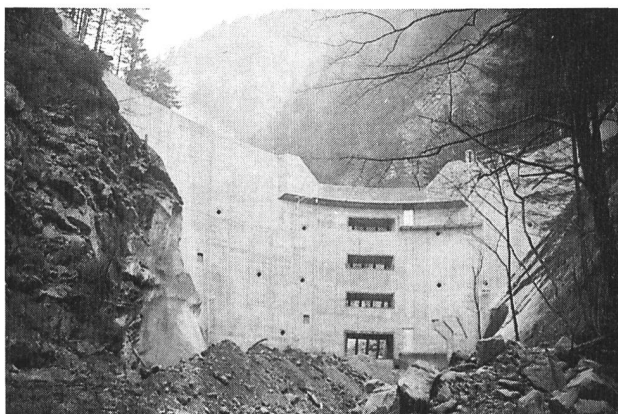
Bild 3. Die Palanggenbachsperre von unten. Über der Grunddole sind drei Entlastungsöffnungen und der Überfall angeordnet.
