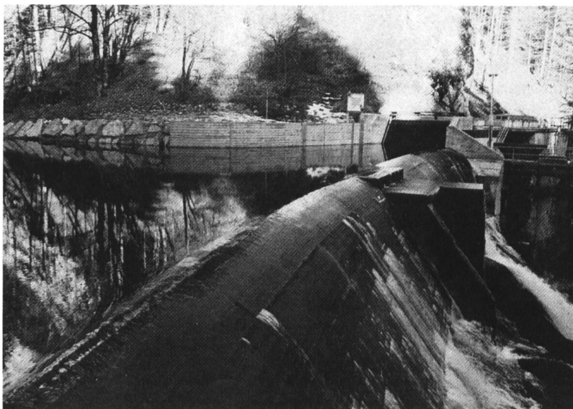
Figure 4. Nouveau barrage et prise d'eau près de la source de l'Areuse.
