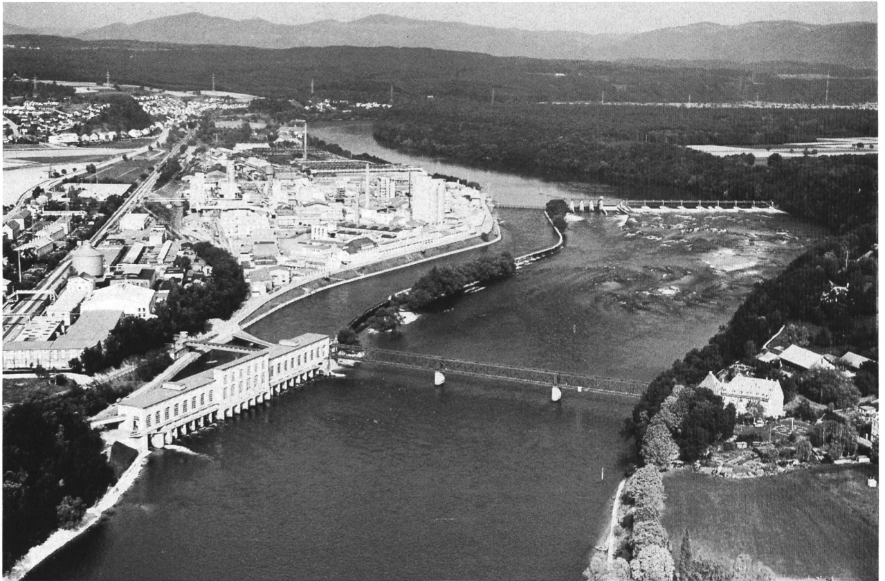
Bild 16. Luftaufnahme des Niederdruck-Kraftwerkes Rheinfelden, eine typische Umleit- oder Kanalanlage (Foto Elektrowatt, Zürich).
