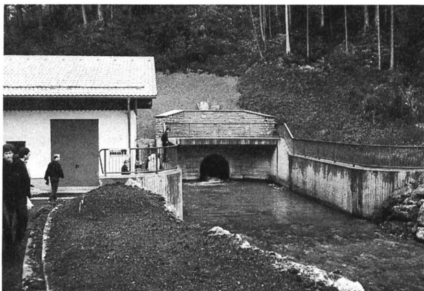
Bild 1. Rottachtalsperre: Auslauf des kombinierten Stollens von Hochwasserentlastung und Grundablass, links im Bild das Zentralengebäude.
