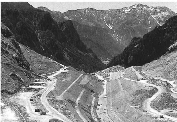
Bild 5. Überlaufkanal im flachen Teilstück. Blick talauswärts (Foto A. Huber).
