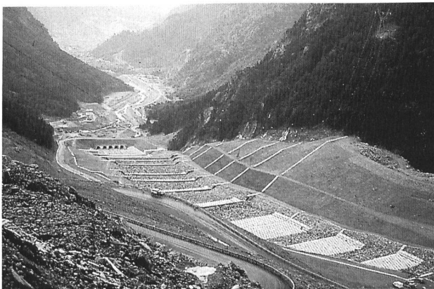
Bild 4. Sperrentreppe im unteren Teil des Schuttriegels. Blick talauswärts (Foto A. Huber).
