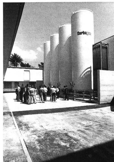
Bild 2. Lagertanks für flüssigen Sauerstoff.
