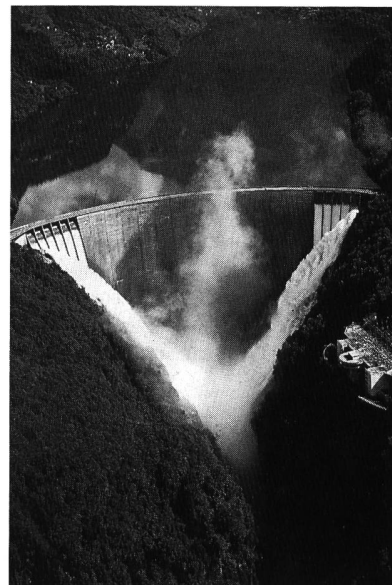
Bild 19. Hochwasserüberfälle der 220 m hohen Bogenstaumauer Contra im Tessin in Betrieb (Foto Verzasca AG, Lugano).
