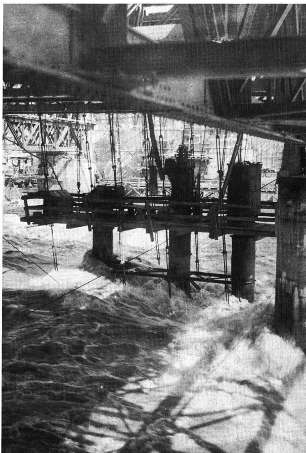
Bild 7. Caisson mit drei Schleusen für die Gründung des Rheinwehres Laufenburg während eines Hochwassers (Foto AG C. Zschokke, Genf).
