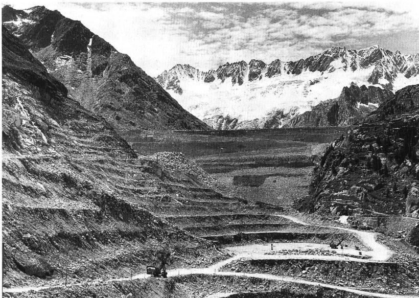
Bild 18. Luftseitige Ansicht des Staudammes Göscheneralp (Foto E. Brügger, Zürich).
