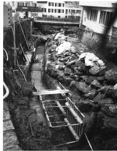
Bild 4. Bau des Druckleitungsabschnitts im Murgbachbett.
