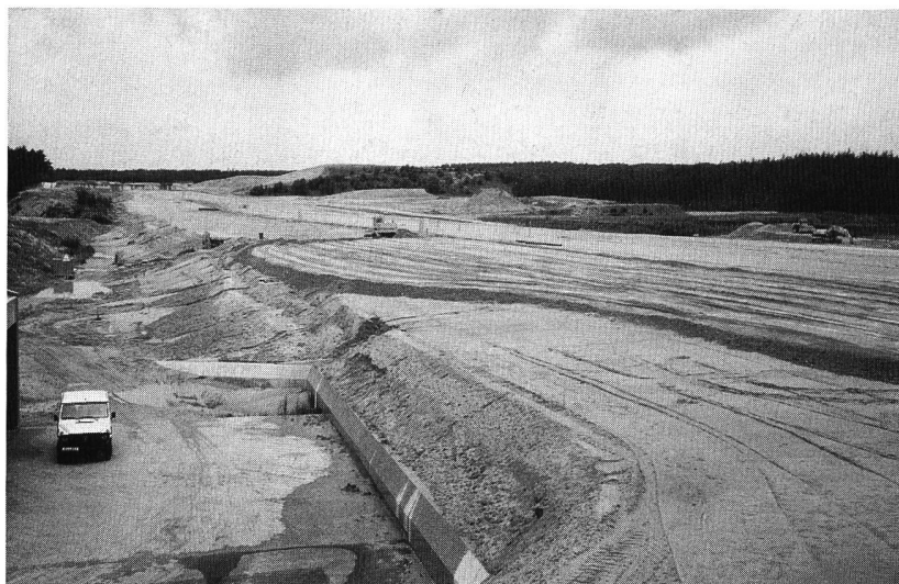
Bild 3. Im Bau befindliche Rothsee-Hauptsperre.
