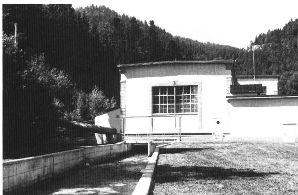
Figure 3. Centrale de La Dernier. Au premier plan, le canal de fuite.
