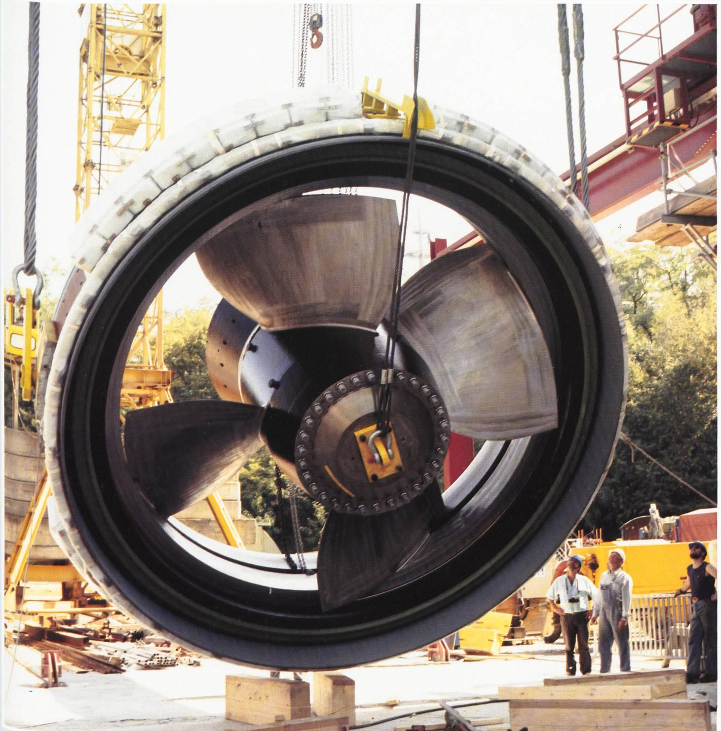
Ausbau Rheinkraftwerk Laufenburg: Laufwerk der Maschinengruppe 1 vor dem Einbau.
