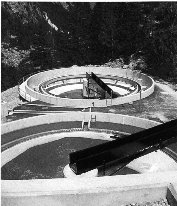
Bild 6. Die beiden Nachklärbecken.
