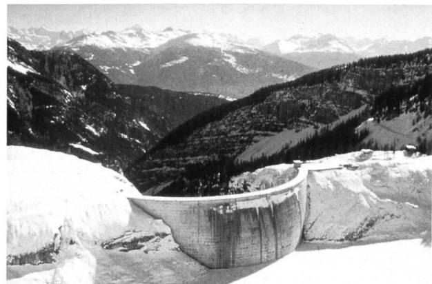
Le barrage de Zeuzier en Valais.
