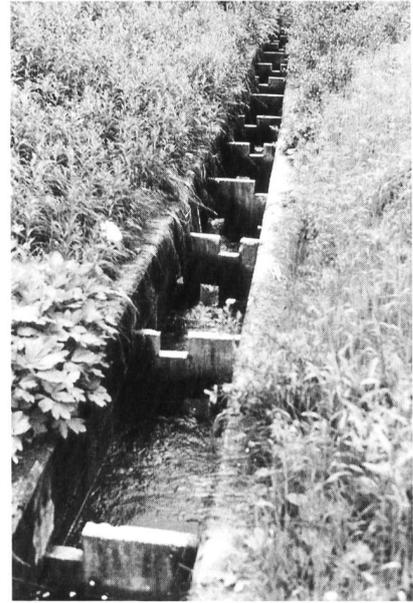
Bild 13. Beckenpass von Charnadura am Inn bei Celerina.
