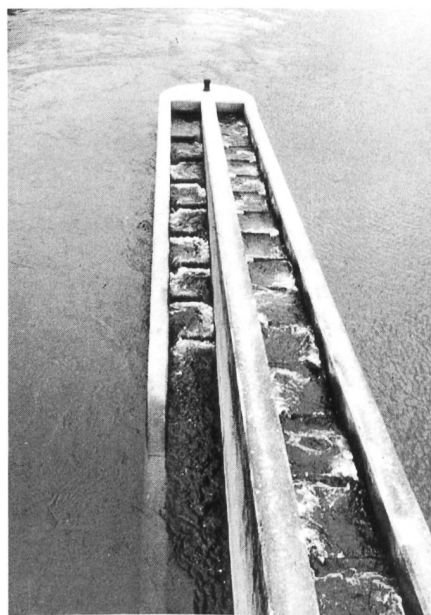
Bild 7. Beckenpass des Mosel-Kraftwerkes Fanken. Anordnung im Heck des Trennpfeilers zwischen Wehr und Zentrale.
