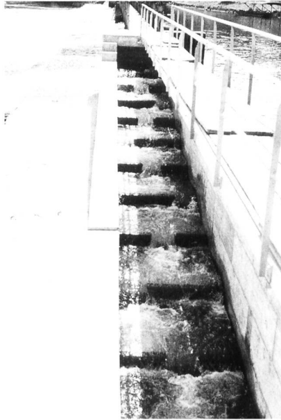
Bild 12. Beckenpass beim Reusskraftwerk Windisch.
