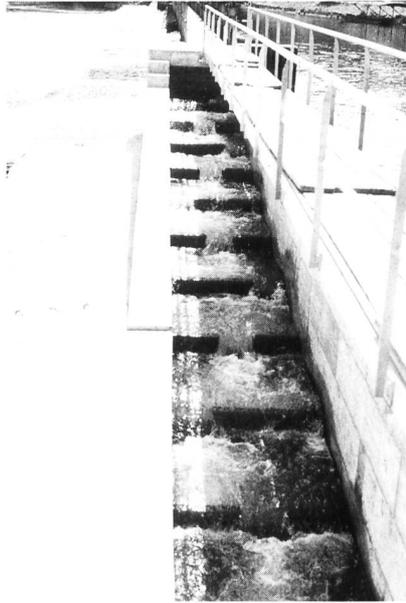
Bild 12. Beckenpass beim Reusskraftwerk Windisch.
