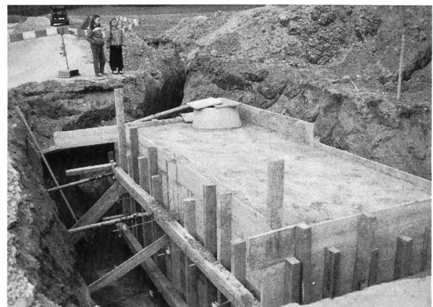
Bild 2. Wasserzähler- und Druckregulierungsschacht in Liebistorf. Bis Ulmiz muss der Wasserdruck auf 6 bis 7 bar reduziert werden. Pumphaus und Wasserreservoir erübrigen sich. Foto: Ueli Gutknecht
