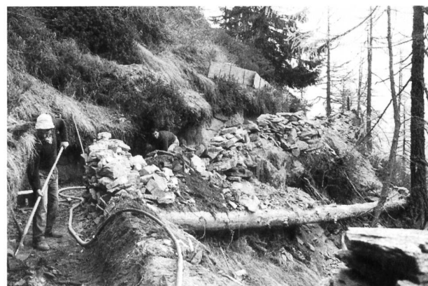
Bild 8. Das Trasse für die Hangleitung wird vorbereitet. Zweimal mussten rund 1300 m teils in felsigem und exponiertem Gelände überwunden werden.
