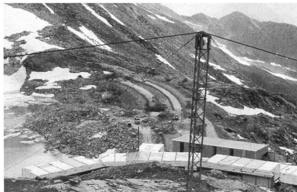
Bild 6. Bereits nimmt der Damm Konturen an. Erkennbar sind die Stützkörperschichten mit dem Böschungsschutz beidseitig des Kerns. Im Vordergrund des Barackendorf und die Reparaturwerkstätte.
