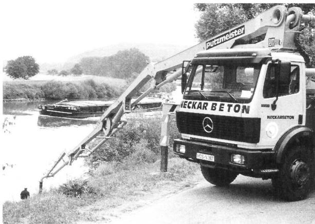
Bild 1. Einbau des Transportbetons mit einem Unterwasser-Zusatzmittel direkt vom Transportbetonfahrzeug aus (Addiment).
