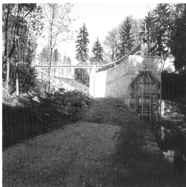
Bild 10. Hochwasserentlastungsbauwerk mit Grobrechen vor Drosselöffnung.
