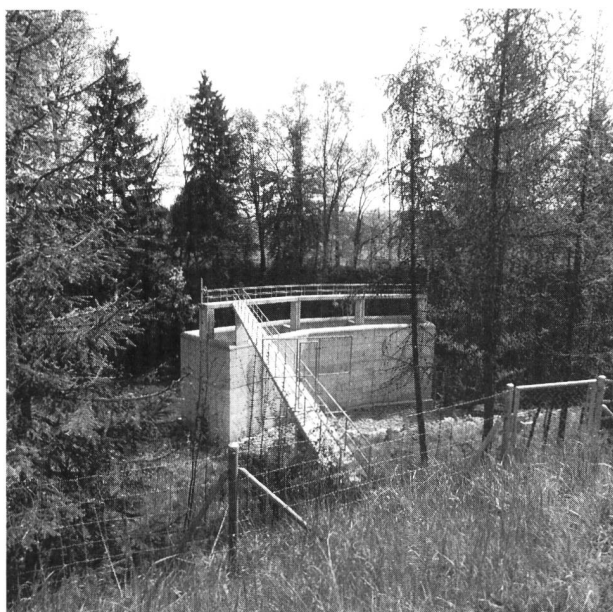
Bild 9. Hochwasserentlastungsbauwerk mit Zugangssteg (Blick vom Stassendamm).
