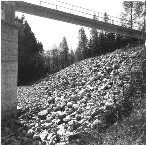
Bild 3. Blockschüttung zur Sicherung der Dammböschung.
