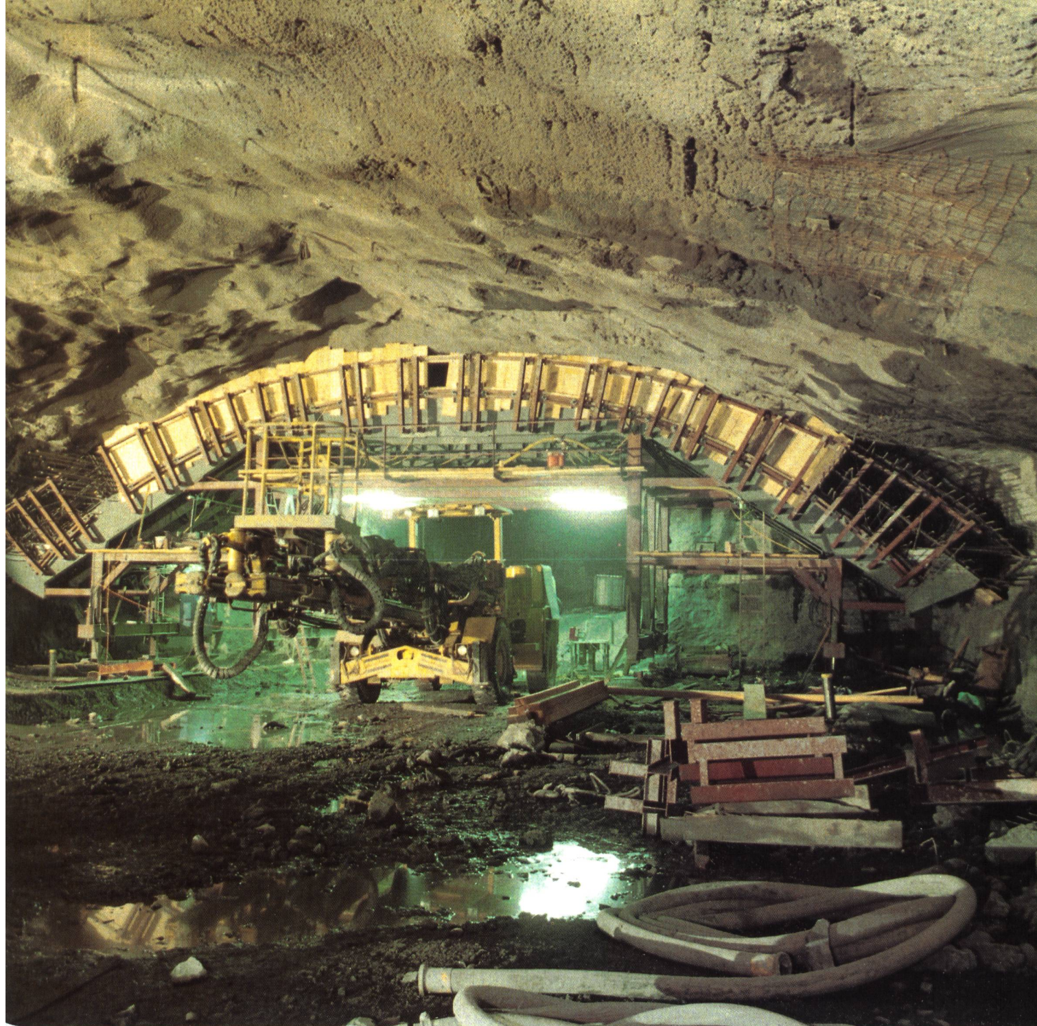
Kavernenzentrale Unteraa. Schalungen für die Betonverkleidung der Kalotte.
