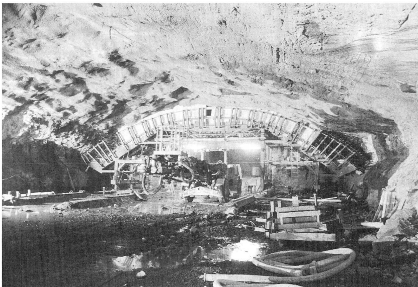
Bild 5. Kavernenzentrale Unteraa. Schalwagen für die Betonverkleidung der Kalotte.
