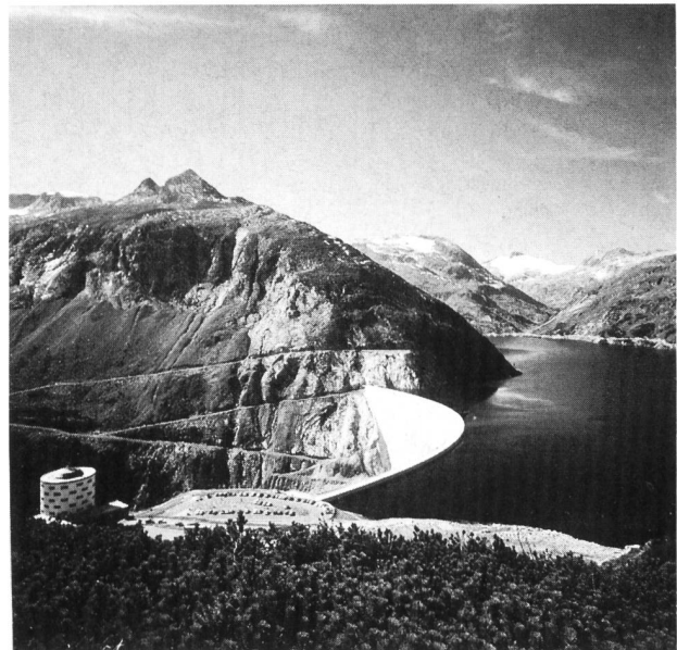
Bild 2. Vollstau der Kölnbreinsperre nach der Sanierung.
