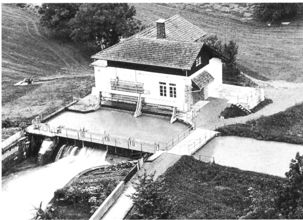
Von der Planung bis zur Installation von zu modernisierenden und neuen Kleinwasserkraftwerken im Leistungsbereich bis 5000 kW ist eine Domäne der ABB Mittelspannungstechnik AG. Das Bild zeigt das KW Hürlimann der K. Hürlimann Söhne AG in Brunnen (SZ), das vor einiger Zeit durch ABB komplett modernisiert und automatisiert wurde.
