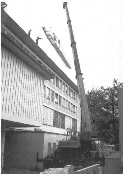
Bild 1, links. Mit einem Pneukran wird ein Träger des neuen Kranes auf die Dachterrasse des VAW-Gebäudes gebracht. Anschliessend wird er durch eine Fensterlücke in die Versuchshalle geschoben.
