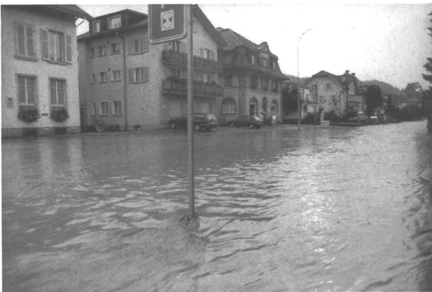
Bild 2. Der Gewittersturm Lea vom 21. Juli 1992 verursachte nebst gewaltigen Hagel- und Sturmschäden auch Wasserschäden in Millionenhöhe. Infolge von Ausbrüchen der Buchwigger wurde das Städtchen Willisau/LU massiv überschwemmt. Das Bild zeigt die Bahnhofstrasse als friedlich dahinmurmelnenden Fluss. Foto: J. Schaller, Foto-Video, Willisau.
