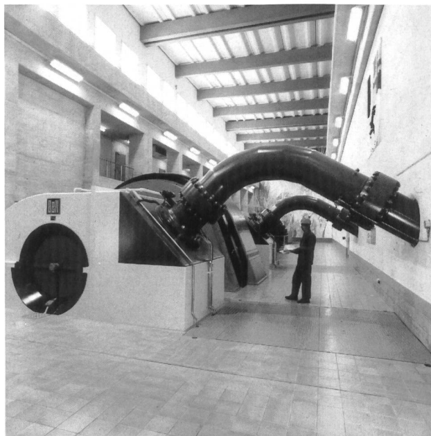
Bild 1. Der Maschinensaal der Zentrale Ilanz wird von den beiden KWI-Kraftwerkstufen gemeinsam genutzt. Die Maschinengruppen verfügen zusammen über eine installierte Leistung von 84 000 Kilowatt (Foto: NOK).
