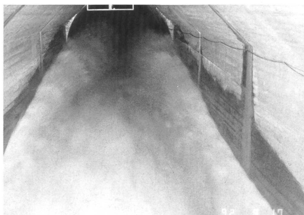
Bild 5. Grundablassabfluss im Bereich der Vereinigungskammer Grundablassstollen – Hochwasserentlastung. Deutlich sichtbar sind die Stosswellen infolge der Gerinneaufweitung (Grundablassstollen – Vereinigungskammer) und der anschließenden Gerinneeinengung (Vereinigungskammer – Unterwasserstollen). Blick in Strömungsrichtung. Der Stauspiegel lag bei 1447,5 m ü. M., woraus eine Druckhöhe von zirka 47 m resultierte; bei einer Schützensöffnung von 120 cm betrug der Grundablassabfluss in Abbildung 4 30 m 3 /s. (Foto J. Speerli, VAW)
