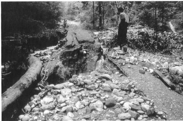
Bild 7. Walderschliessungsstrasse mit grösserem Längsgefälle nach dem 23. Juni 1993. Rechts oben ist ein Auflandungsdelta erkennbar, links ein Erosionstrichter im Strassenkörper mit neuem Bachgerinne.
