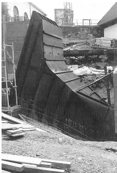
Figure 2. Blindage amont turbine en cours de montage.
