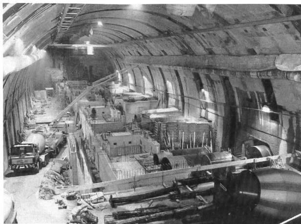
La caverne d'Unteraa de la centrale du Lungernsee, pendant l'aménagement intérieur. Une fois la rénovation achevée, la caverne de 87 m de long et de 26 m de large abritera 4 groupes turbine-alternateur et produira sur une année moyenne 76 millions de kWh.
